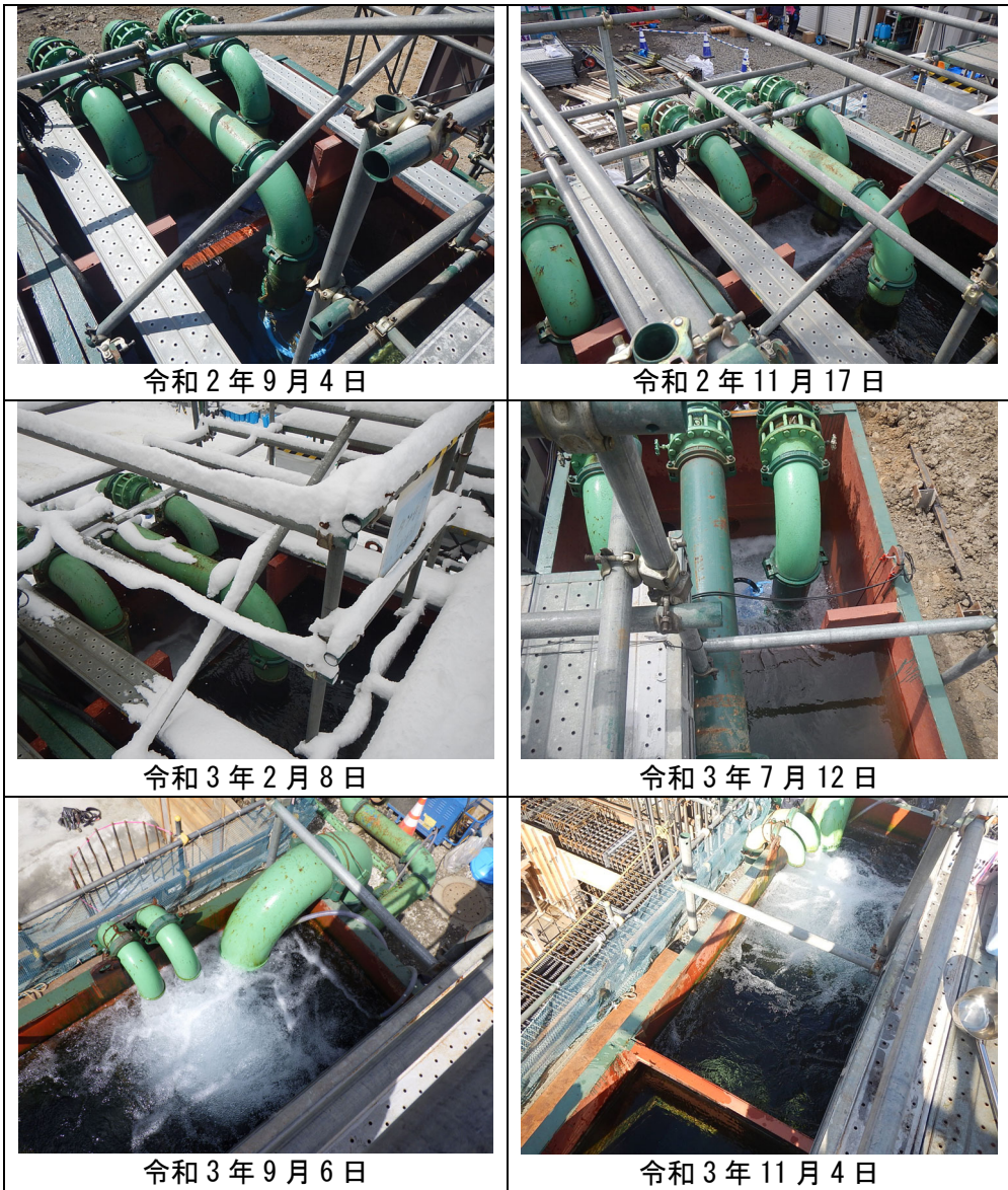
写真 7-1-2 水質調査地点（ノッチタンク）の状況
