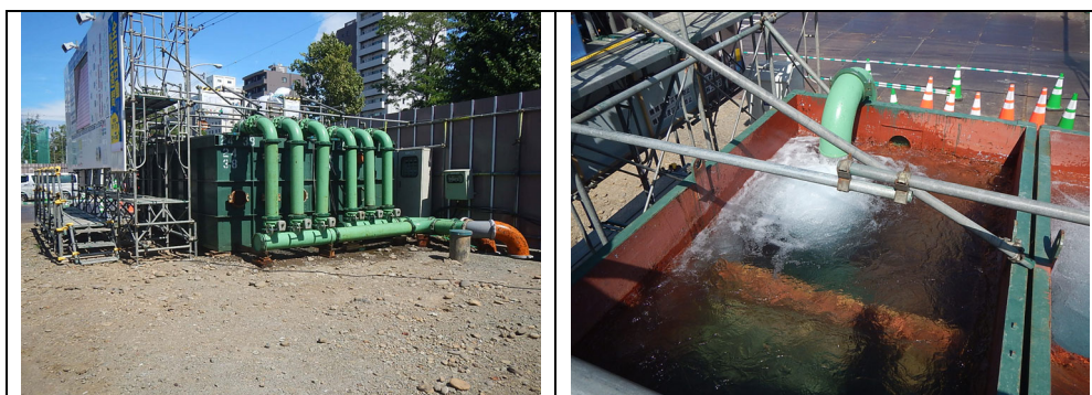
写真 7-1-3 ノッチタンク（仮設沈砂槽）の状況（令和2年9月4日）
